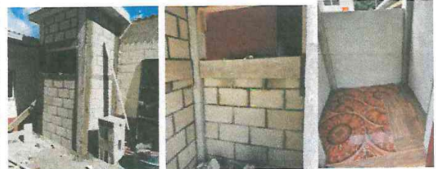
Foto 4: Remodelación para depósito de basura (sellado y tallado)
