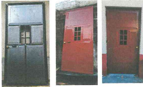
Foto 3: Instalación y suministros para puertas de metal, cocina, aulas y depósito para basura
