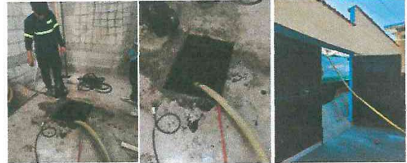
Foto 2: Mantenimiento de fosa séptica (Extracción de desechos orgánicos)
